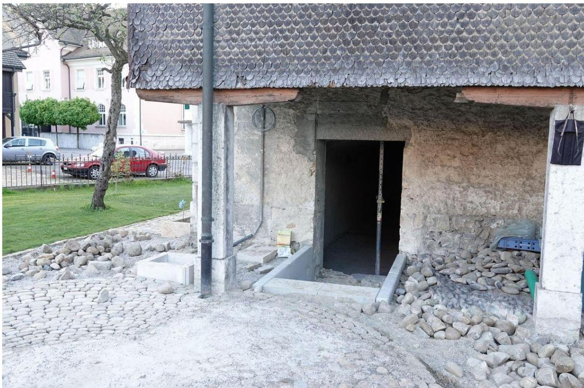
Der neue Notausgang: Dafür musste ein dickes Mauerwerk durchbrochen werden.
